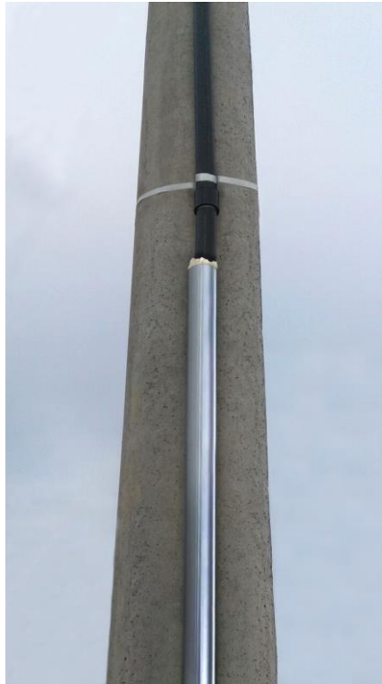
Foto ilustrativa 01 dos anexos D, E, H e I – Detalhe do eletroduto junto ao poste
